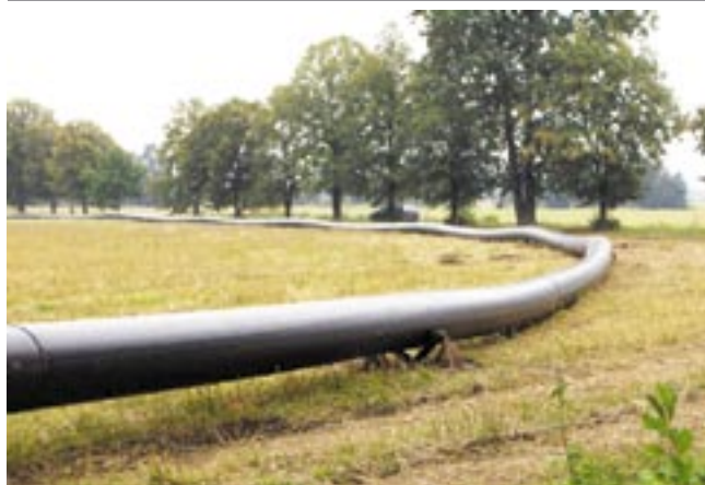
Fot. 7. Przygotowany do wprowadzenia odcinek rurociągu
