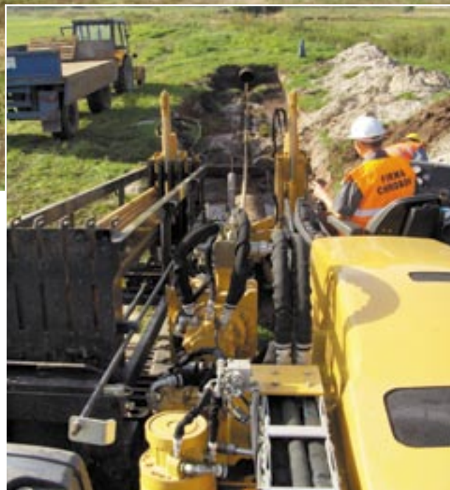
Fot. 2. Przeciąganie rury w komorze roboczej
