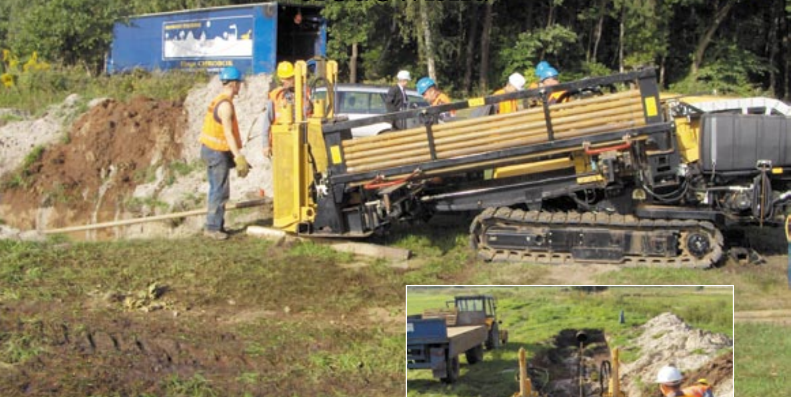
Fot. 1. Prowadzenie żerdzi pilotażowej
